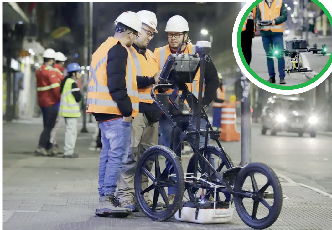
Georradar usado para mapear tubulações subterrâneas sem necessidade de escavações
