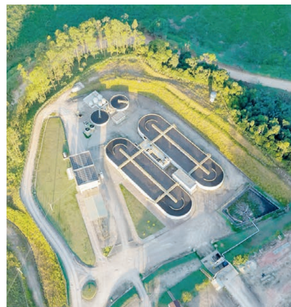
Estação de tratamento de efluentes da Veolia
