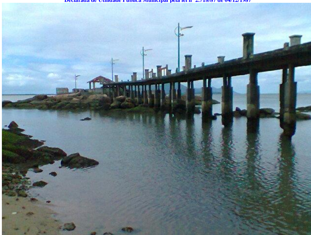
FIGURA 5 - Situação da rede e dos postes de iluminação pública.
