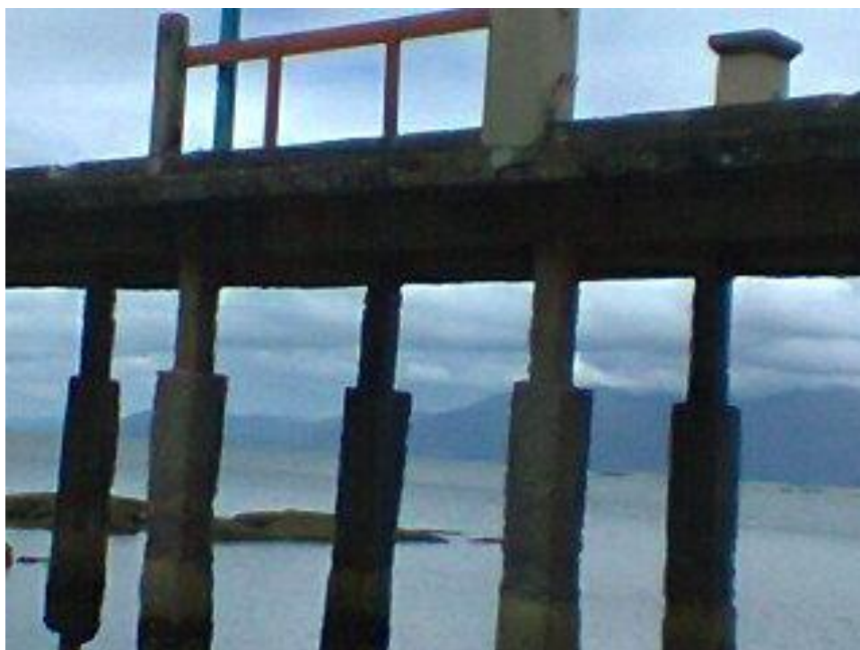
FIGURA 4 - Passarela e Pilares de Superfície, superior e inferior
