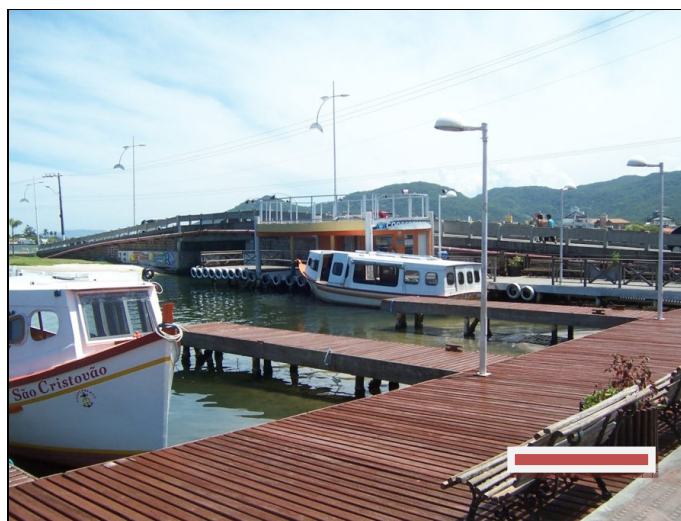
Figura 29: Terminal de passageiros do transporte aquaviário, que faz a rota Centro da Lagoa - Costa da Lagoa,) e em primeiro plano, estruturas de apoio náutico adjacentes.
